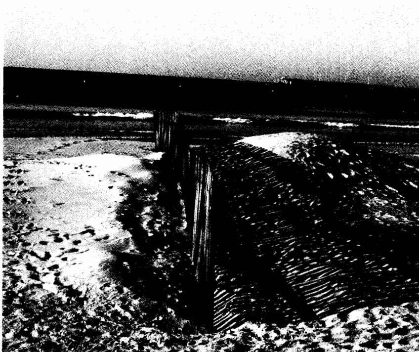
Fig. 8. Colocación losas hormigón como técnica de acumulación de arena y fijación de dunas. A la dcha., fig. 9. Actuación del tablestacado como "técnica blanda" para la acumulación de arena y fijación de dunas.
